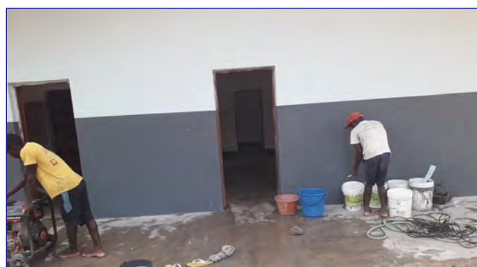
Dipintura esterna della nuova struttura. Nella parte inferiore sono state usate vernici lavabili.
