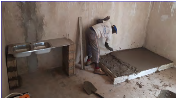
Lavori per la costruzione della cucina, che fornirà a regime ogni giorno pasti per circa 400 allievi e insegnanti.
