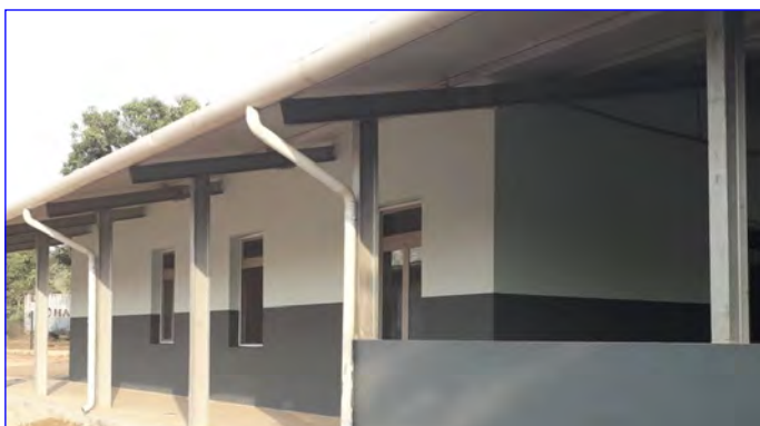
Una vista laterale del nuovo edificio. Si nota in particolare il porticato esterno che è collegato tramite una passerella alla scuola Sambù.
