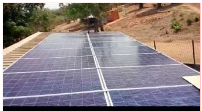
I lavori di completamento dell'impianto fotovoltaico
