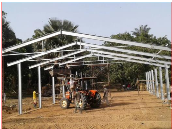
Montaggio della struttura metallica sulla base di cemento precedentemente gettata
