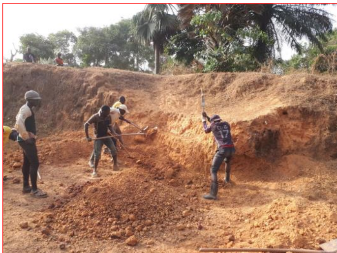
La cava di sabbia e ghiaia per la preparazione del calcestruzzo e la fabbricazione dei mattoni
