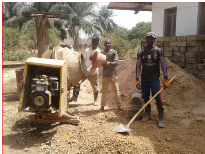
Si prepara il calcestruzzo per gettare le fondamenta del nuovo edificio e la costruzione dei mattoni
