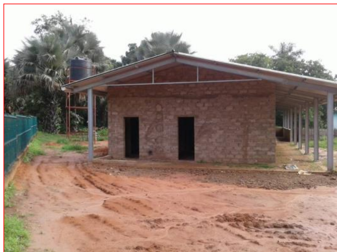
Dalla struttura metallica alla muratura, al montaggio del tetto e delle grondaie
