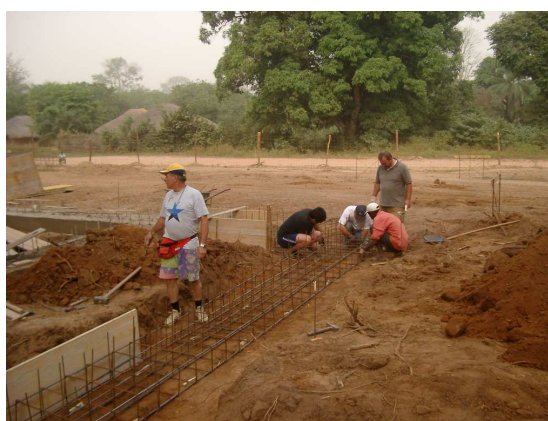
Inizio lavori di fondazione della scuola
