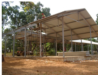
Copertura della scuola
