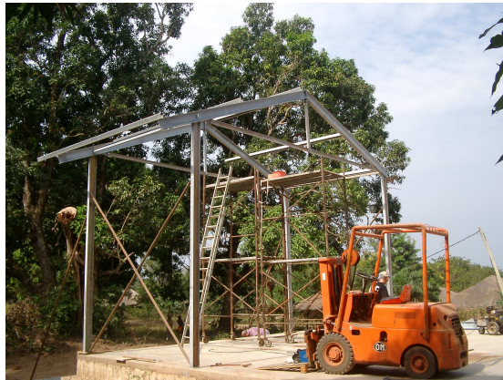
Struttura prefabbricata della scuola
